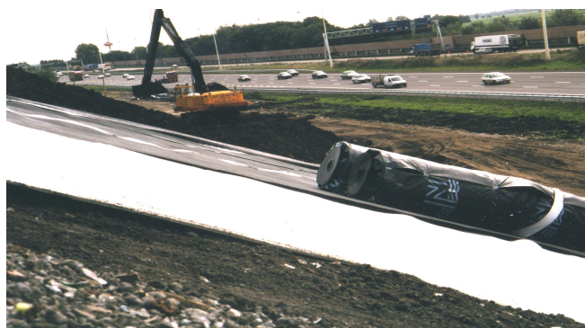
Combinatieafdichting met secugrid A12 De Meern
