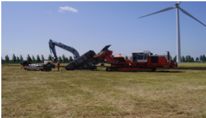
Aanbrengen tijdelijk kwelscherm
