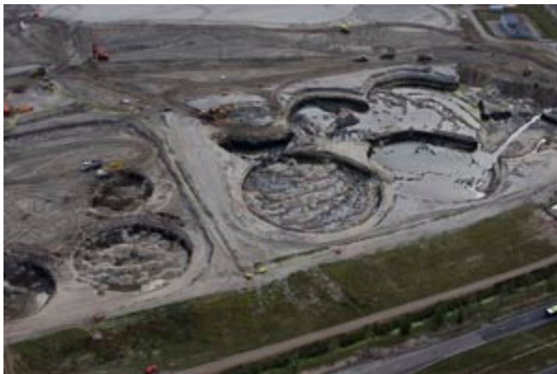
Luchtfoto grondverzet en verdichting van zand op het Vopakterrein te Amsterdam
