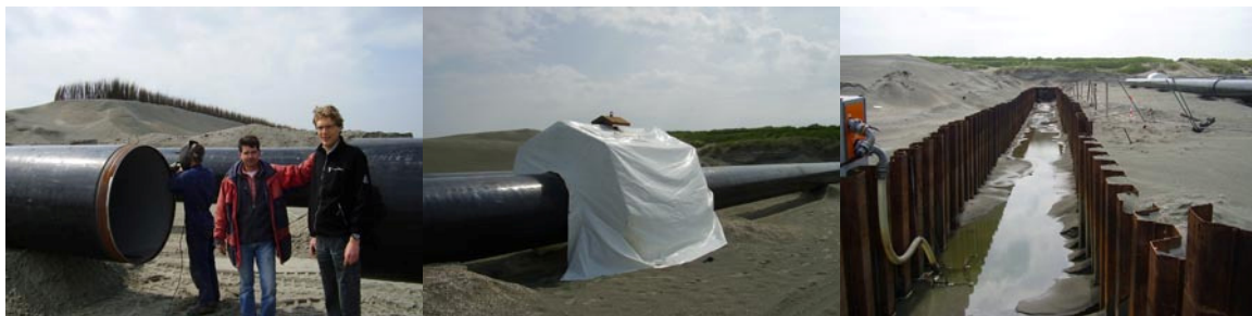
Vorbewerken en lassen van de persleidingen
