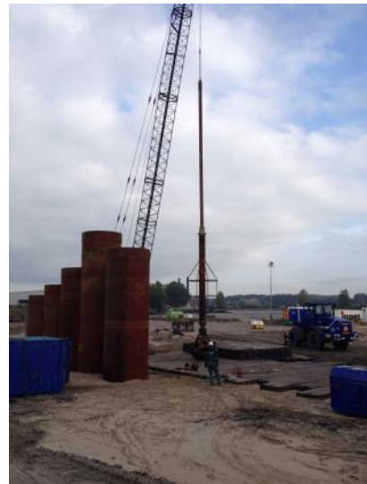
Ankerstangen en de door Strabag (ippel betonwerken) aangeboden methode van stalen casings.
