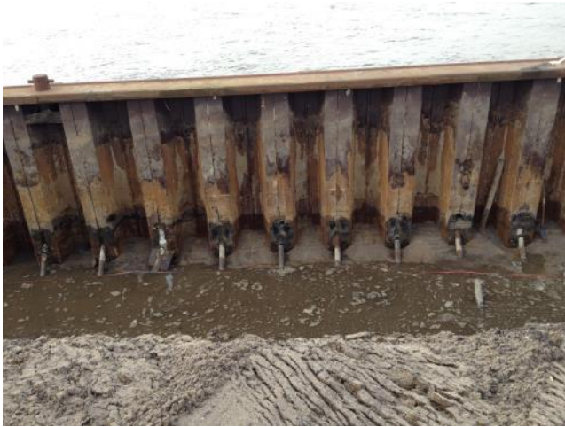
Ankerstangen en de door Strabag (ippel betonwerken) aangeboden methode van stalen casings.
