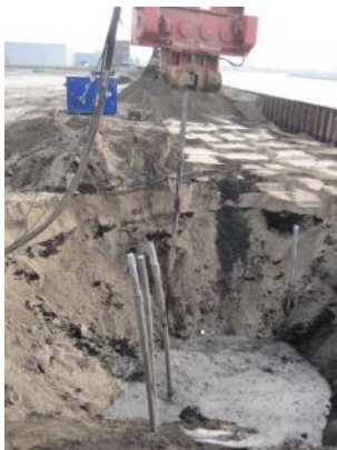
Trekken aan de ankerstaven
