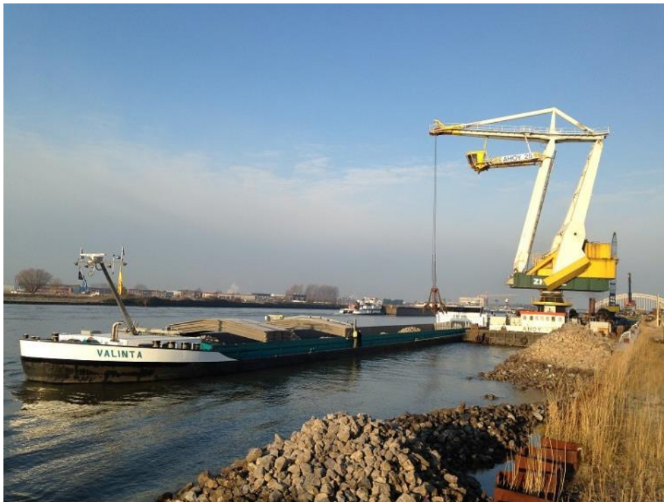
Levering breuksteen voor de bodembescherming
